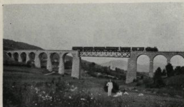
Otovski viadukt, ko vozi po njemu vlak dolenske železnice.
