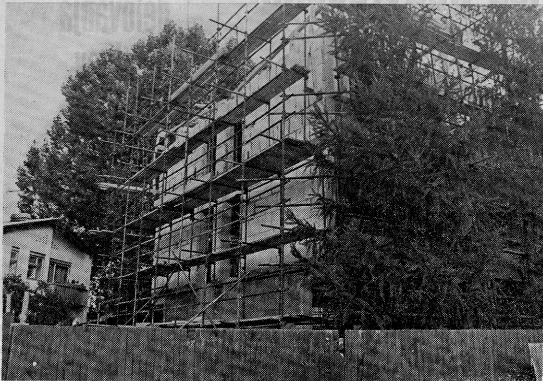
Gradnja prizidka dobro napreduje in vse kaže, da bo končana do predvidenega roka, kar je tudi želja vseh delavcev DSSS.
