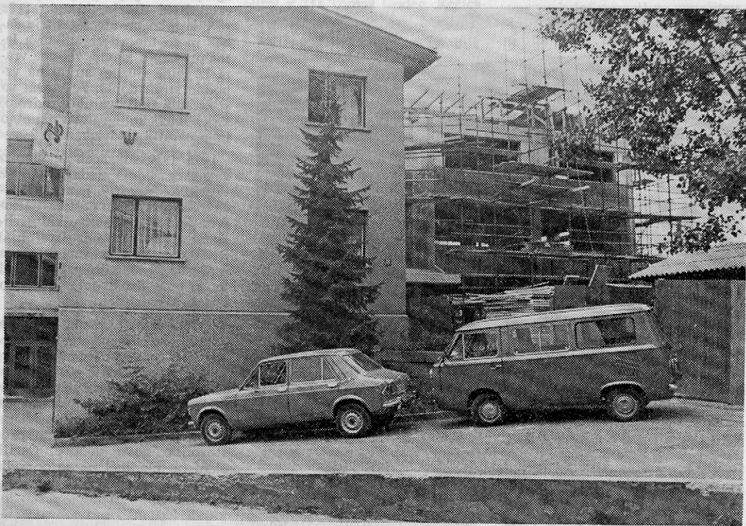
Prizidek je dozidan; pričetek postavljanja ostrešja.
