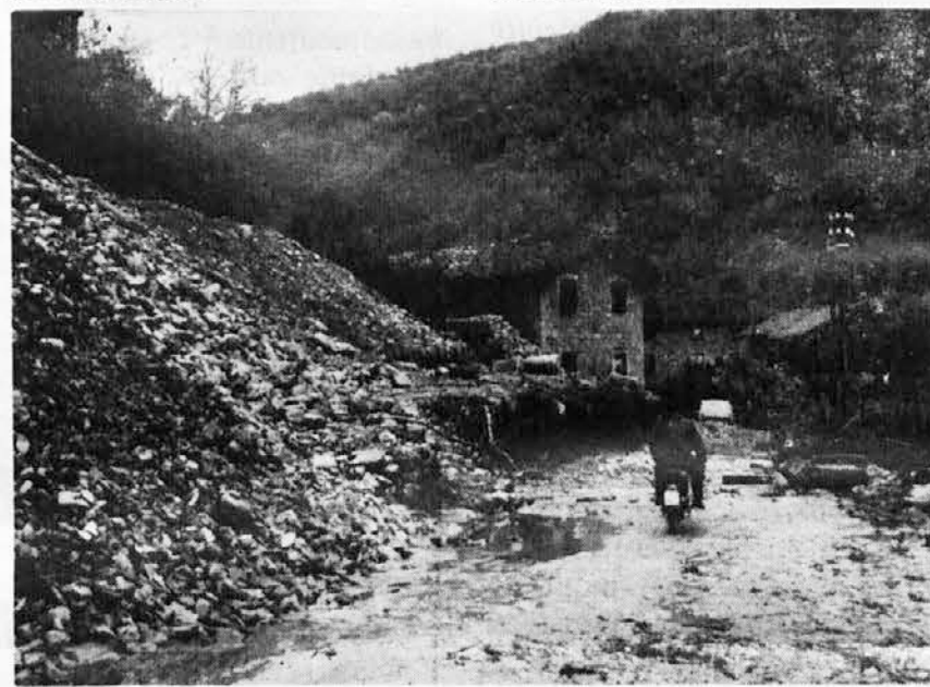
Zalosten videz del cesti Podklap nad Fojdo, ki je utrpela največ škode zaradi silne vodne vihr.
