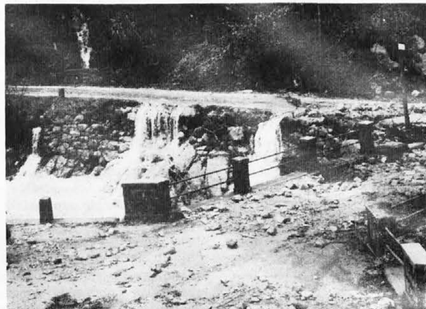
Voda, kamenje in plazovi so napravili velik nered na mostu pri Podklapu.
