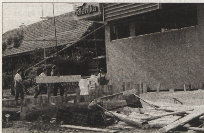
OBNOVA TREBANJSKE BLAGOVNICE - Najmlajše slovensko mesto počasi dobiva lepšo podobo. K temu bo pripomogla tudi prenovljena trebanjska blagovnica Dolenjka d.o.o. v križišču, kjer se zavija na avtocesto. Že nekaj časa je zaradi preurejanja zaprta. Prav te dni je na gradbišču zelo živahno. Investitor del je Dolenjka, izvajalec pa Unitehna iz Trebnjega. (Foto: L. Murn)
