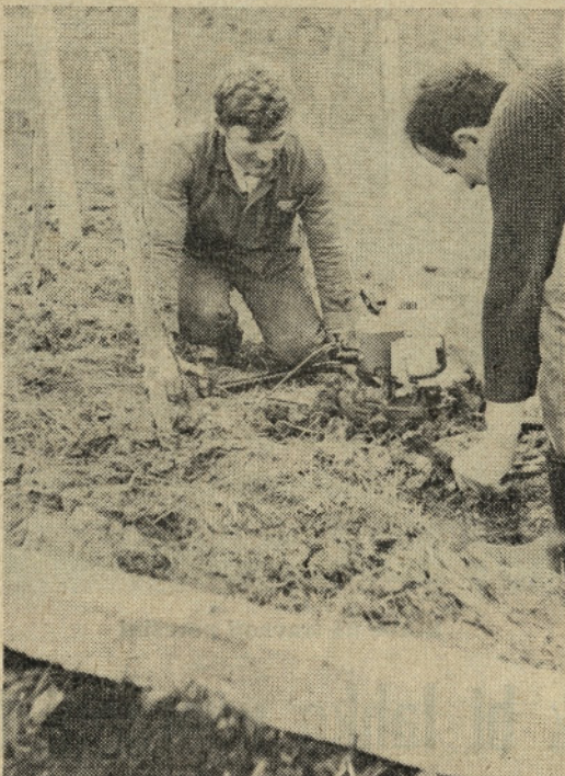
Z motornim svedrom hitro izkopljemo jame za drogeve
