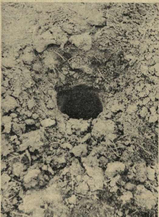
Motorno zvrtna luknja za betonsko oporo
