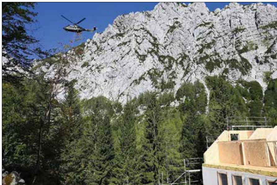
Na gradbišče je bilo treba s helikopterjem in tovorno žičnico pripeljati precej materiala oziroma elementov, ki so jih pripravili v delavnici.
