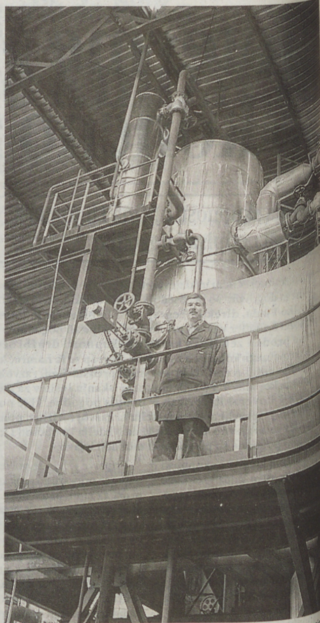
Ivan Krpan se je povzpel v parno »postrojenje« in na vrhu pokazal izmenjevalec toplote, ki omogoča zajemanje pare ob razplinjanju in njeno vračanje v tehnološki proces, kar omogoča prihranek pri kurilnem olju in prispeva k zmanjšanju onesnaženosti ozračja. (Foto: Š. S.)
