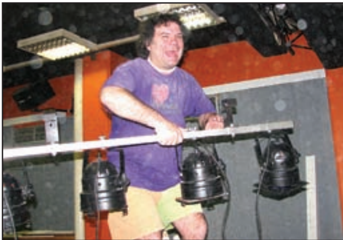
Na prepleškane stropne je bilo treba namestiti reflektorje. To so bila še zadnja dela v obnovljenih prostorih.
