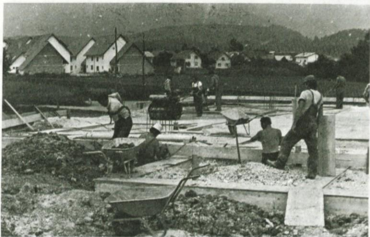
Gradnja mrliške vežice se je pričela v predvidenem roku. Betonski bloki iz belega in navadnega cementa bodo vgrajeni v belih in sivih pasovih brez ometa po zamisli ing. arh. Marka Cotiča. (foto: Zdenko L.)
