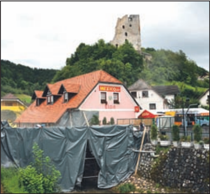
Mosta v Šaleku bodo povsem prenovili, zato bodo porabili 70.000 evrov, končali pa ga bodo do konca oktobra.
