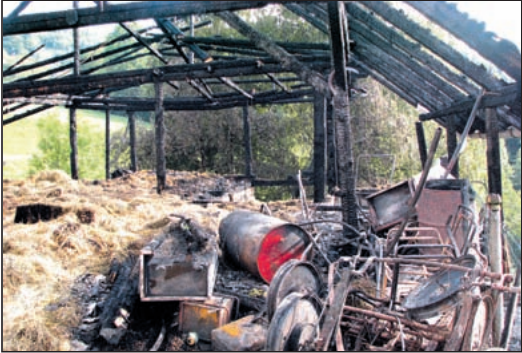
Marsikaj je uničenega tudi v stanovanjskem objektu.
