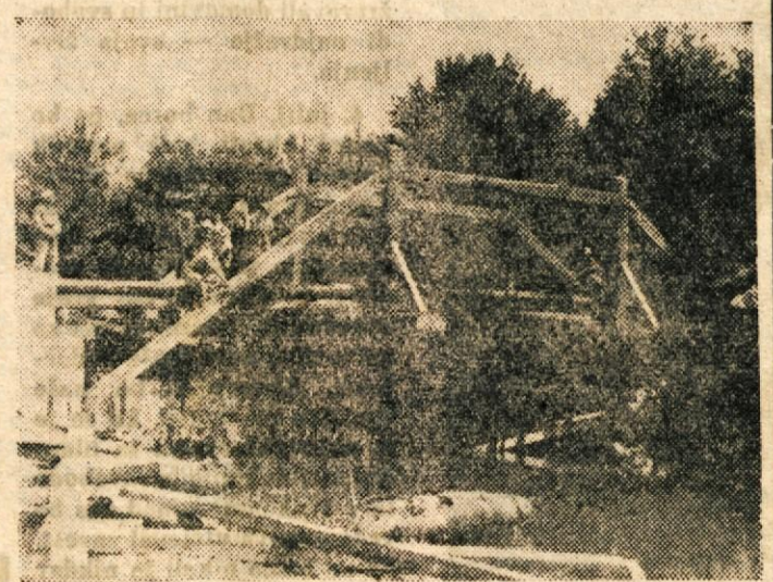
Novi most čez Dobljčiko med gradnjo
