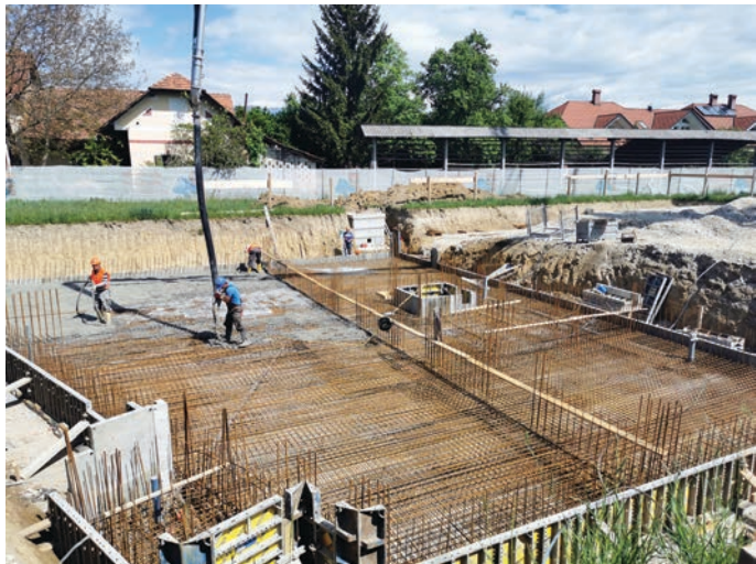
Potem ko so januarja naredili zakoličbo, so po prvomajskih praznikih 2020 začeli betonirati temelje.
