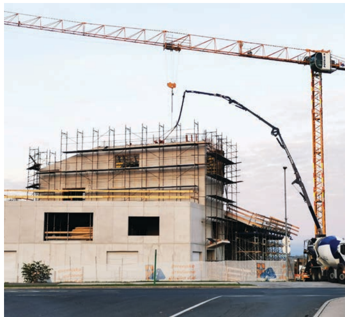
Sredi oktobra se je začela gradnja stolpa, ki je najbolj značilni element gasilskih domov, saj ga gasilci uporabljajo za sušenje cevi. Tudi popraznični dnevi niso ustavljali del. Betoniranje 2. novembra 2020.
