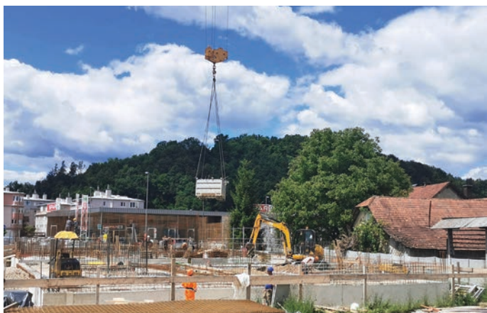
Gradnja je napredovala hitro in konec maja 2020 je bilo na gradbišču videti že marsikaj.
