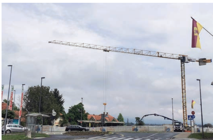
Na občinski praznik 15. maja 2020 je žerjav na gradbišču že nakazoval, kako visok bo objekt.
