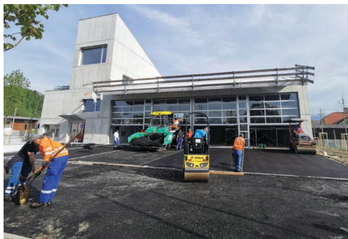
Asfaltiranje ploščadi 10. maja 2021
