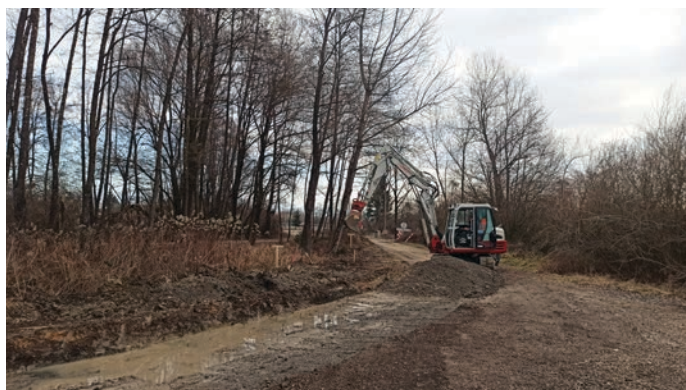
Izvajalec del je pri izkopu pričakovano naletel na talno vodo.
