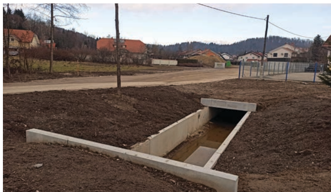
Po zacevitvi potoka Blatnica je na območju gradbišča že nekaj časa makadam in čaka na gradnjo kolesarske povezave.
