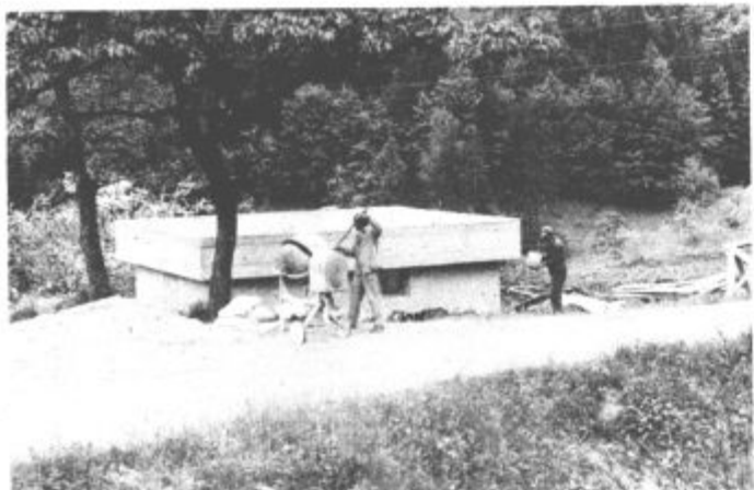
Črpališče v Podkraju, ki je v zaključni fazi, bo napajalo vodovod Ruperče–Tajna
