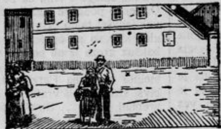
Gostilna pri Šikcu v Vegovi ulici — podrta.
