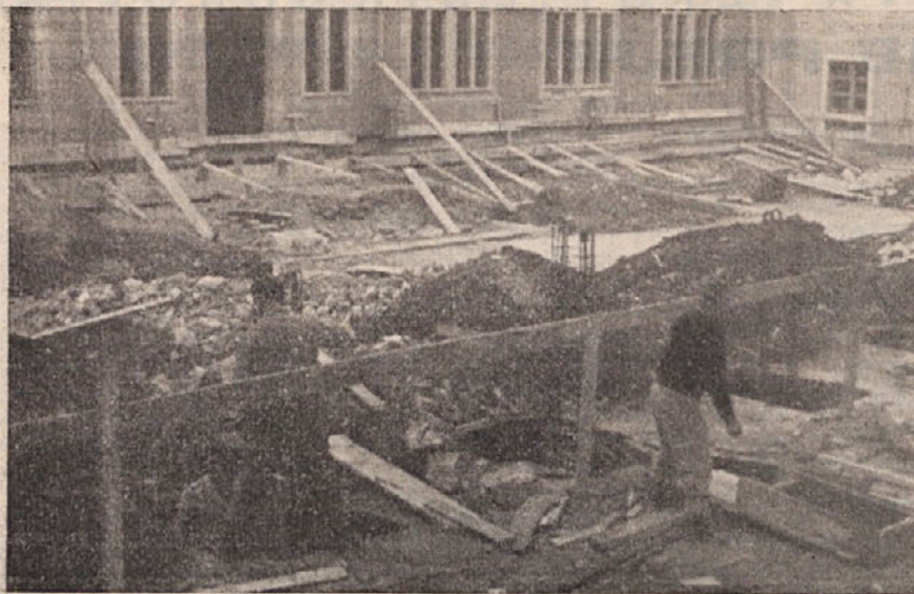
Gradnja prizidka za halo nove oplemenitilnice je v polnem razmahu
