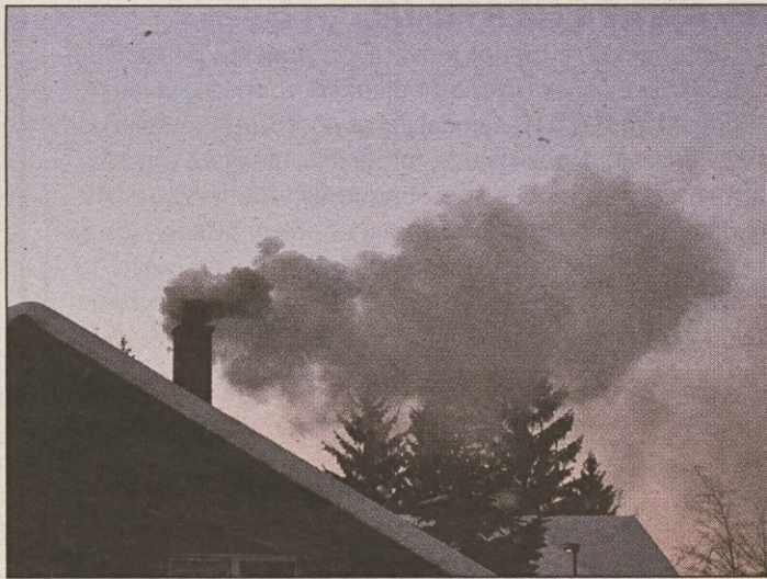
Črn (temen) dim je znak slabega izgorevanja, ne glede na energent. Ob manjšem izkoristku kupljene energije (drva, kurilno olje,...) po nepotrebnem in zelo obremenjujemo zrak.
