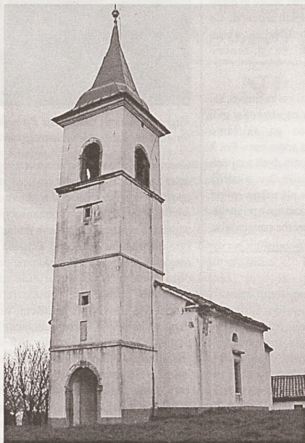
V zgornjem delu kraja stoji cerkev sv. Frančiška Asiškega. Zadnjič je bila obnovljena fasada, leta 1989.
