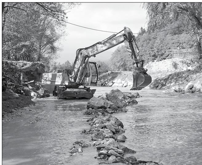
Medtem ko se urejajo zunanji oporniki, brežine in struga, se izdeluje tudi železna konstrukcija za nov most.
