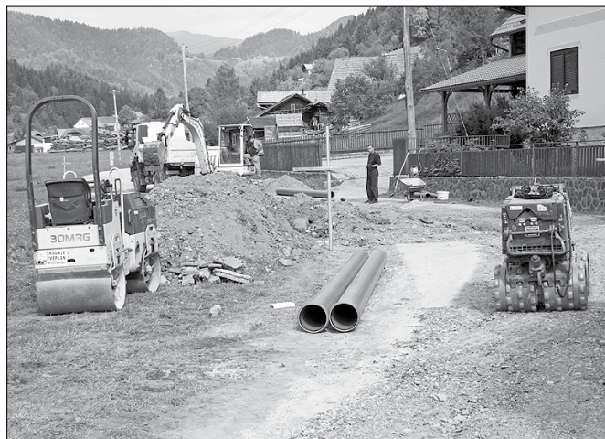
Dela na kanalizaciji v Juvanju potekajo v smeri od regionalne proti središču vasi. (Foto: Marija Lebar)
