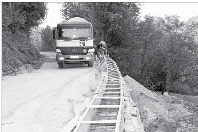
Pogled na območje sanacije v času izvajanja del (Foto: Marija Lebar)
