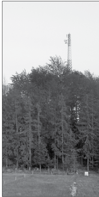
V okviru projekta je bilo zgrajenih 13 postaj odprtega širokopasovnega omrežja. (Foto: Štefka Sem)
