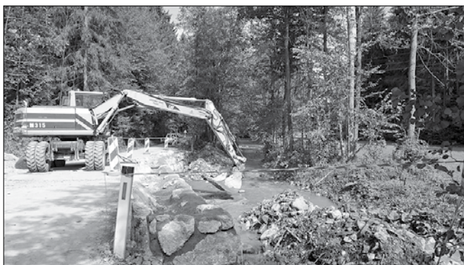
Sanacija vodotoka proti Lepi Njivi (Foto: Štefka Sem)
