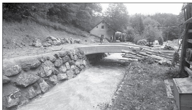
Sanacijska dela na mostu v Dol-Suhi so skoraj zaključena, sledi še sanacija plazu. (Fotodokumentacija Občine Rečica ob Savinji)
