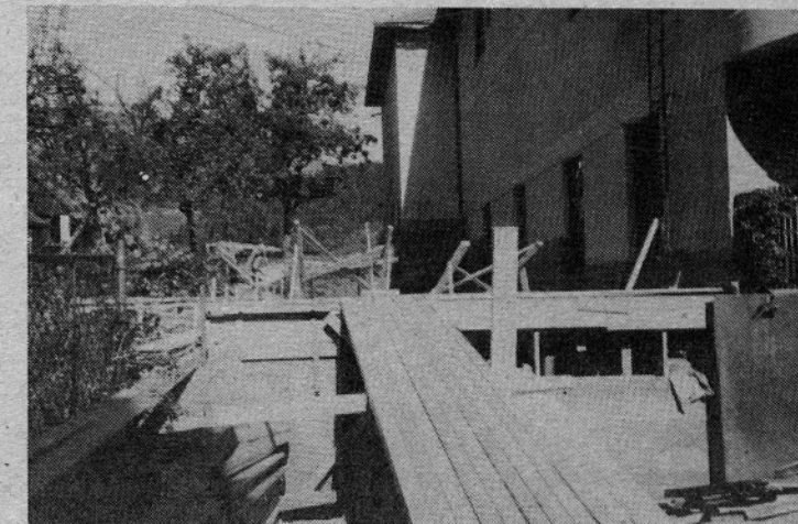
Pri Kulturnem domu v Mozirju raste nov prizidek. Novi prostori bodo namenjeni knjižničarski in galerijski dejavnosti. Zaradi premajhnih prostorov je že bila pod vprašaj postavljena matičnost knjižnice. Dve tretjini sredstev bo prispevala krajevna skupnost Mozirje iz sredstev samoprispevka, eno tretjino pa bosta zbrali Zveza kulturnih organizacij občine Mozirje in Prosvetno društvo Mozirje.
