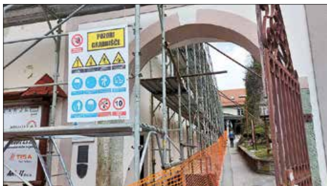
Po začetnih posegih na fasadi se je izkazalo, da bo potrebnih nekaj dodatnih del.
