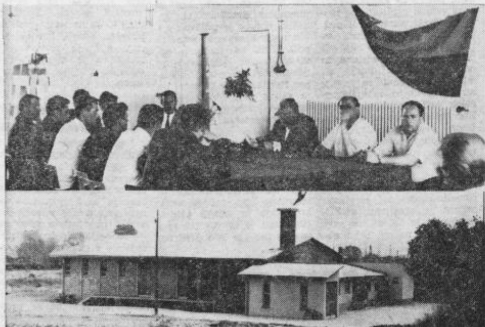
Dva posnetka s slavnostne otvoritve novih delovnih prostorov obrtnega podjetja Steklar v Celju. Zgoraj — med sejo delavskega sveta, spodaj — novi delovni prostori ob Teharski cesti. (Foto: M. Božič)
