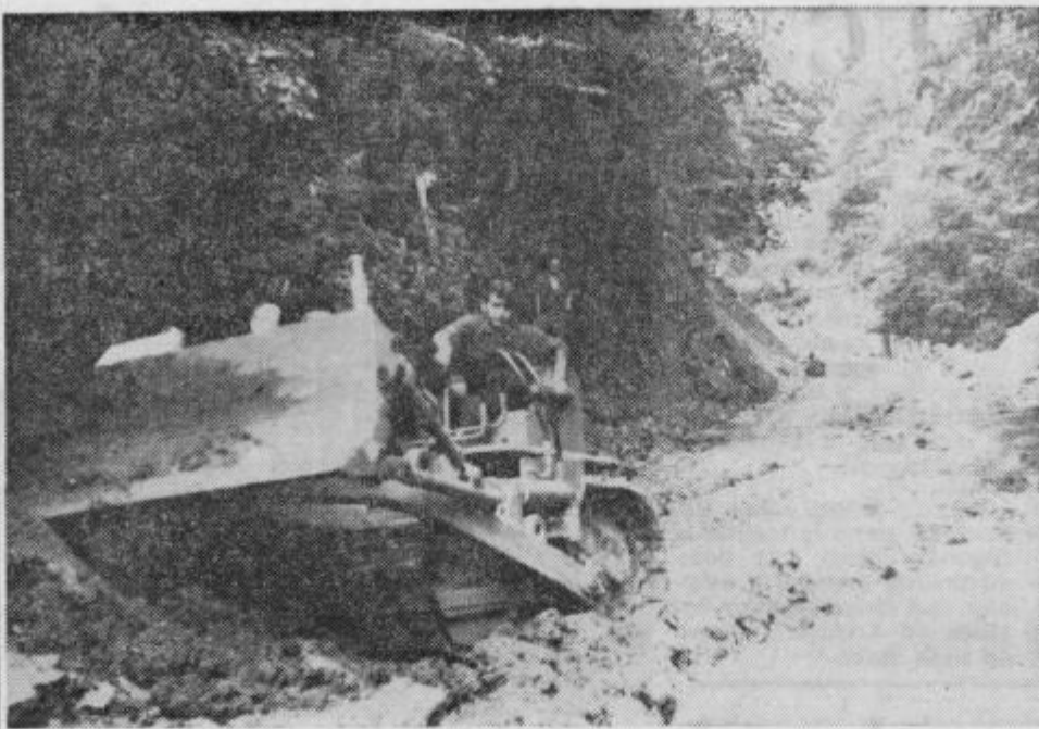
DELO PRI GRADNJI CESTE SMARJETA-DOL DOBRO NAPREDUJE
