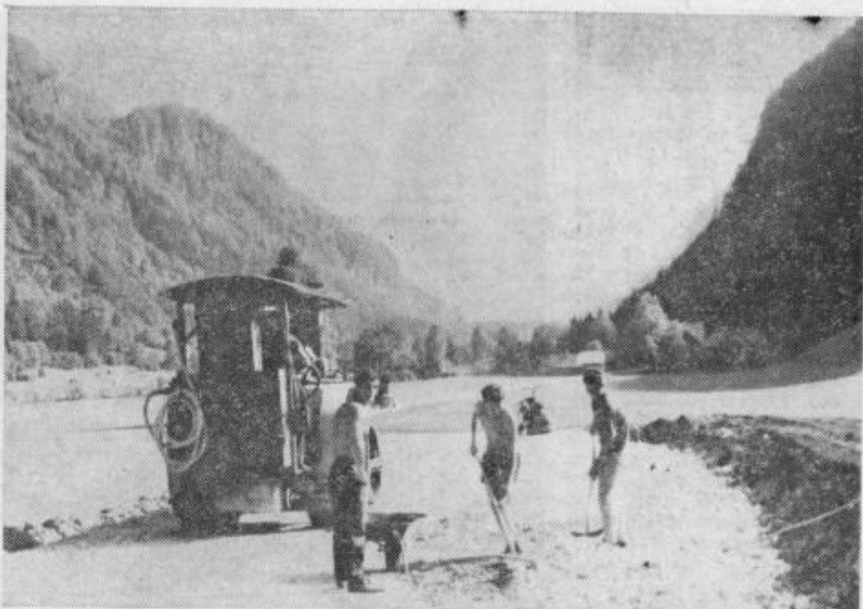
ASFALT PO LOGARSKIM. Delavci Cestnega podjetja iz Celja v teh dneh opravljajo zemeljska dela za asfaltiranje in rekonstrukcijo ceste v Logarski dolini od slapa Rinke do Logarjevih sestra. Tako je prvič v zgodovini ropot valjarja vznemiril tisočletni mir pod vršaci, katerih venec objema Plesnikov in Robanov svet. Foto: J. Sever
