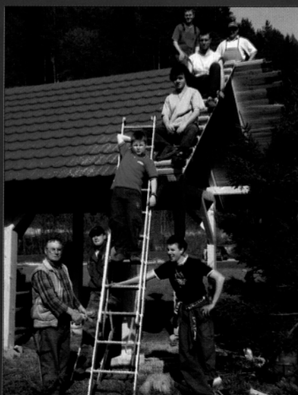
Krajanje Ljubije so pomagali pri gradnji vaške vrtno ute (foto: Jože Miklavc)
