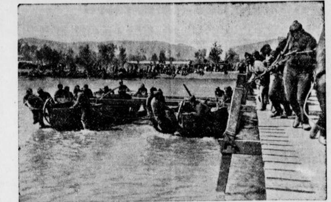
Francove čete delajo pontonske mostove čez reko Cinca, kjer so rdeči ob umiku razstrelili vse mostove
