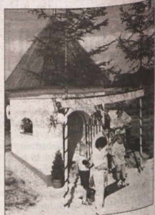
KAPELICA REŠENA - Več let so potniki ob poti, ki pelje po nekdanji rimski cesti, opazovali propadanje kapelice nad Trebčo vsojo pri Dvoru. Vaščani so jo pred kratkim temeljito obnovili in ji dali nekdanji blišč. Pri obnovi sta pomagala tudi slikar samouk Martin Blatnik in rezbar Miha Legan iz Žužemberka. V nedeljo popoldne je dekan Franc Povirk blagoslovil, pri slovesnosti pa je sodeloval tudi cerkveni pevski zbor in Danica Bračič, ki je prebrala odlomek iz Šmarne ter se zahvalila vsem darovalcem. (Foto: S. Mirtič)
