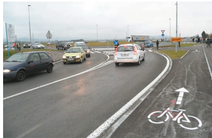
V četrtek, 27. oktobra, je stekel promet po novem pododseku mengeške obvoznice od Slovenske ceste iz smeri Trzina pred vstopom v Mengeš do krožišča Kamniške ceste.
