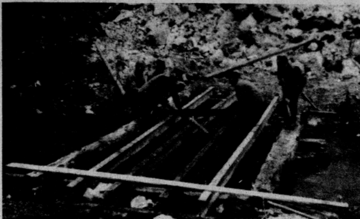
Cesta po dolini Ljubije dobiva sodoben videz. Pridni krajanji pripravljajo nadaljevanje modernizacije te prometne povezave.
