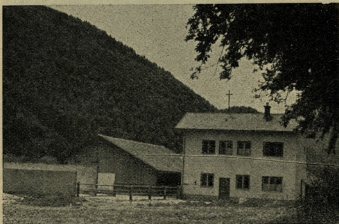
Odprti hlev s severne strani. Desno se vidi zidana stavba, v kateri je spodaj molžišče in mlekarina, zgoraj pa upravni prostori. Levo sta dva prazna koritasta silosa.
