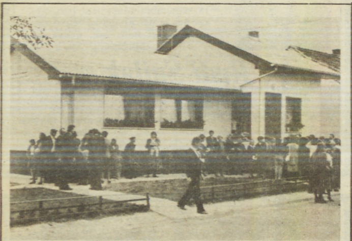
NOV MOLITVENI DOM — S slovesnim bogoslužjem so člani kristusove binkošne cerkve minulo nedeljo v Fokovcih predali namenu nov molitveni dom. Pred poltrajnim letom so porušili prostore starega doma in na tem mestu postavili novega. Vrednost novega doma je več deset milijonov dinarjev, zgradili pa so ga s prostovoljnimi delom in prispevki ter tako zidavo močno pocenili. Foto: L. Kovač
