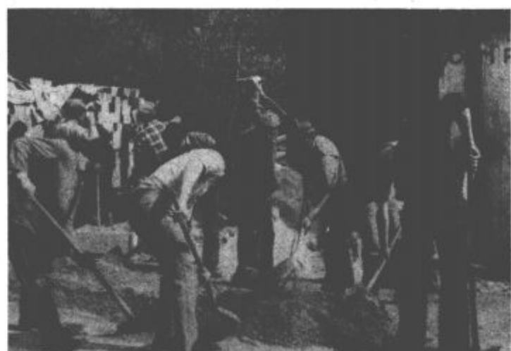
Pri obnovi gasilskega doma je bilo prostovoljcev preveč tudi za tri mesece, zato tudi ročno delo ni bilo odveč
