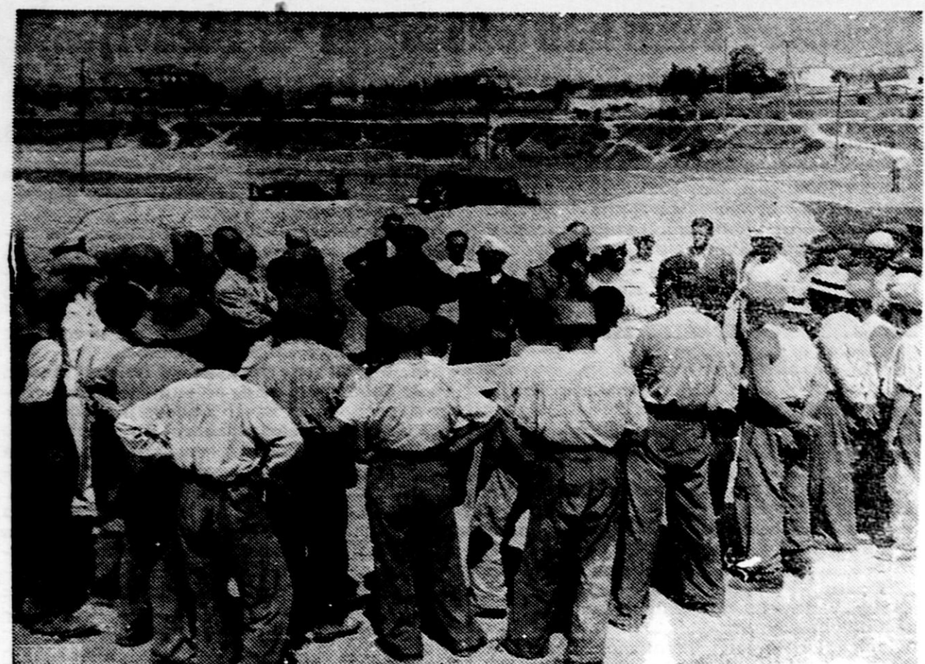
Zastopniki spitskih oblasti med delavci, ki grade novo bolnico
