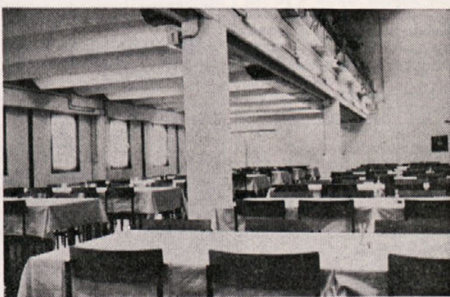
Medetažna konstrukcija je tudi montažna, sestavljena iz stebrov, »U« nosilcev in etažnih »PI« plošč
