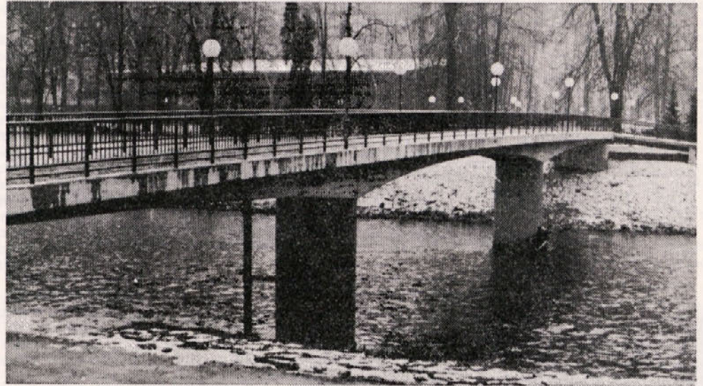
Obnovitev mostu čez Savinjo so delavci TOZD GO Celje izvedli lani.
