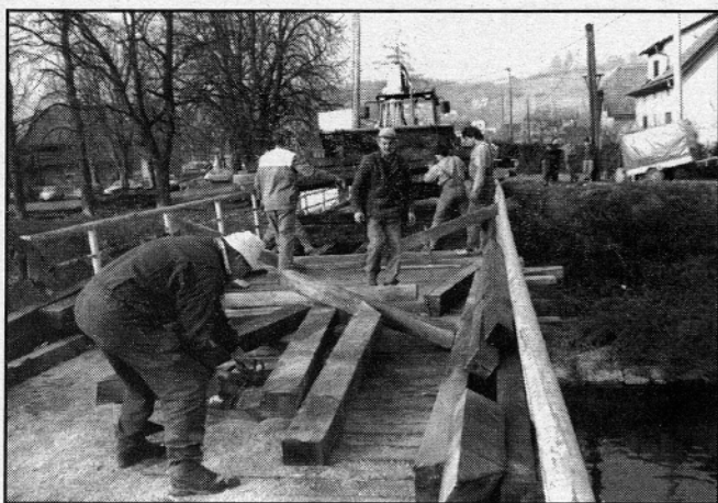
Obnova lesenega dela mostu (foto: Ciril Sem)
