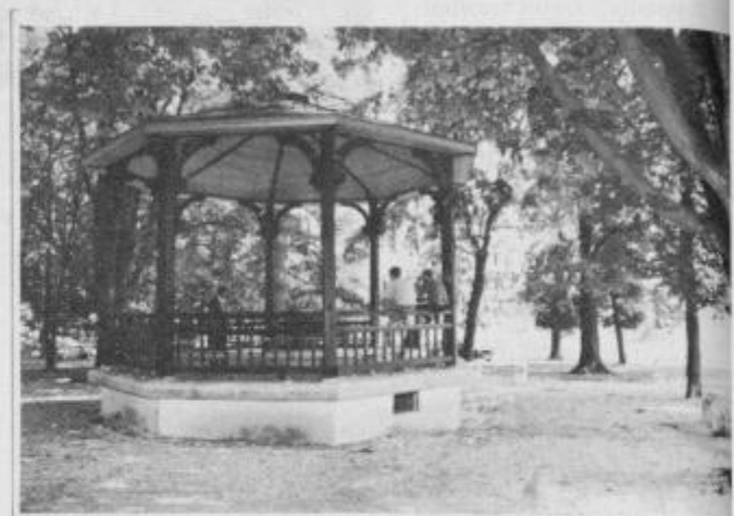
Glasbeni stolp še vedno brez vsebine, zato pa so toliko bolj aktivni vandali. Foto: Kosi
