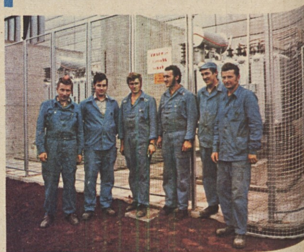
Naši elektromonterji pred dokončano transformatorsko postajo v kranjski „Savi“
