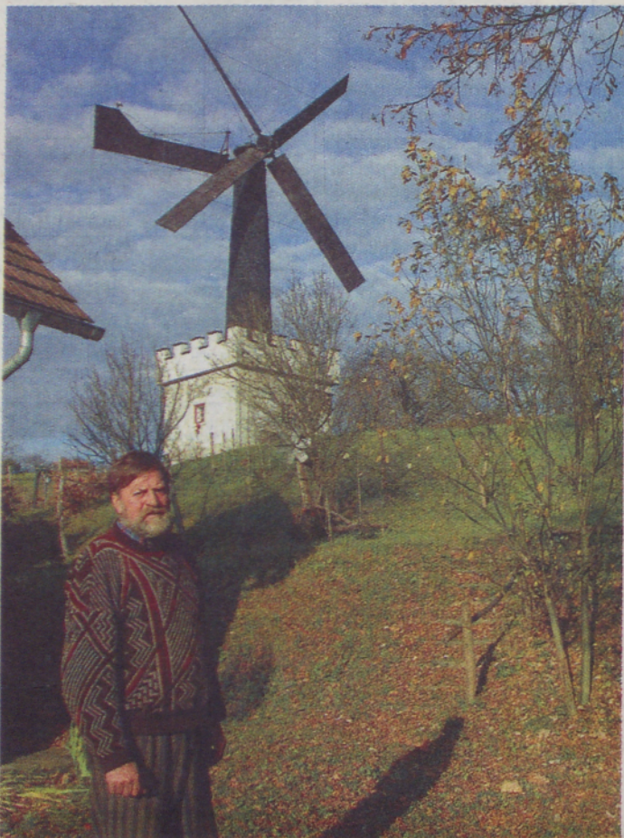
Vogrinov mlin je visok 19 metrov, vetrnice (oba kraka) pa merijo 15 metrov.
