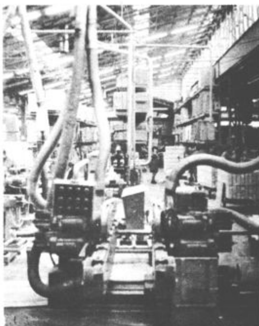
Novi proizvodni prostori za stavbno pohištvo
