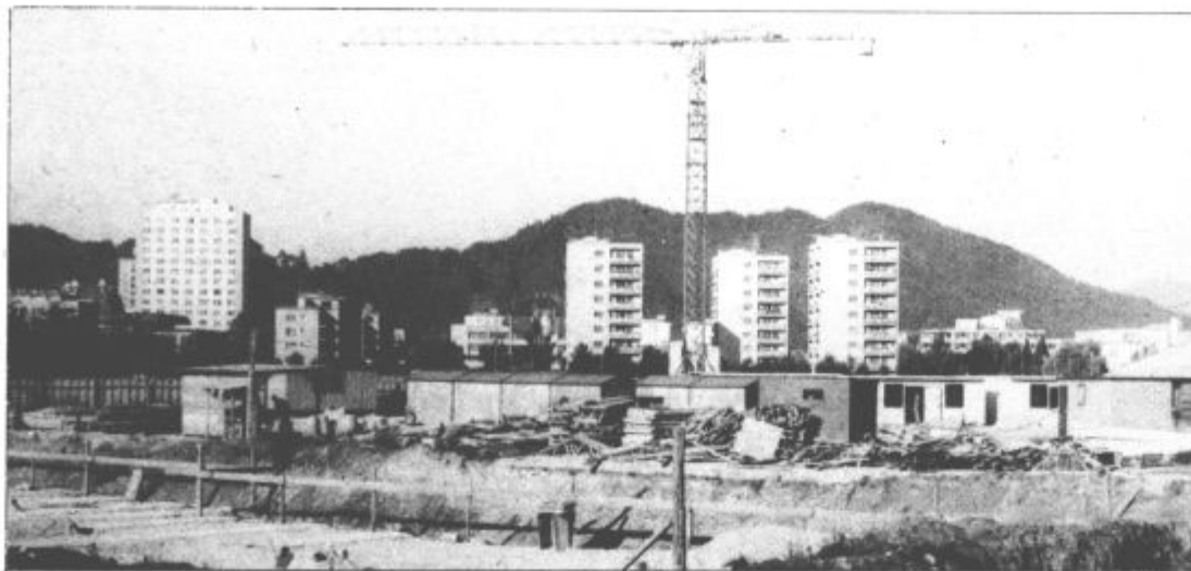
Prostor med Kidričevo in Saleško ceto, vasjo Šalek ter reko Pako (Šalek II) je namenjen za stanovanjsko in poslovno gradnjo. Pred dnevi so na njem že začeli gradbeni dela za stanovanjski del.
