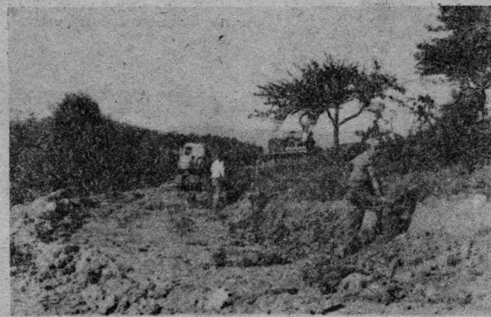
Obsežna zemeljska dela za novo stanovanjsko sosesko v Mozirju opravlja Komunalno podjetje
