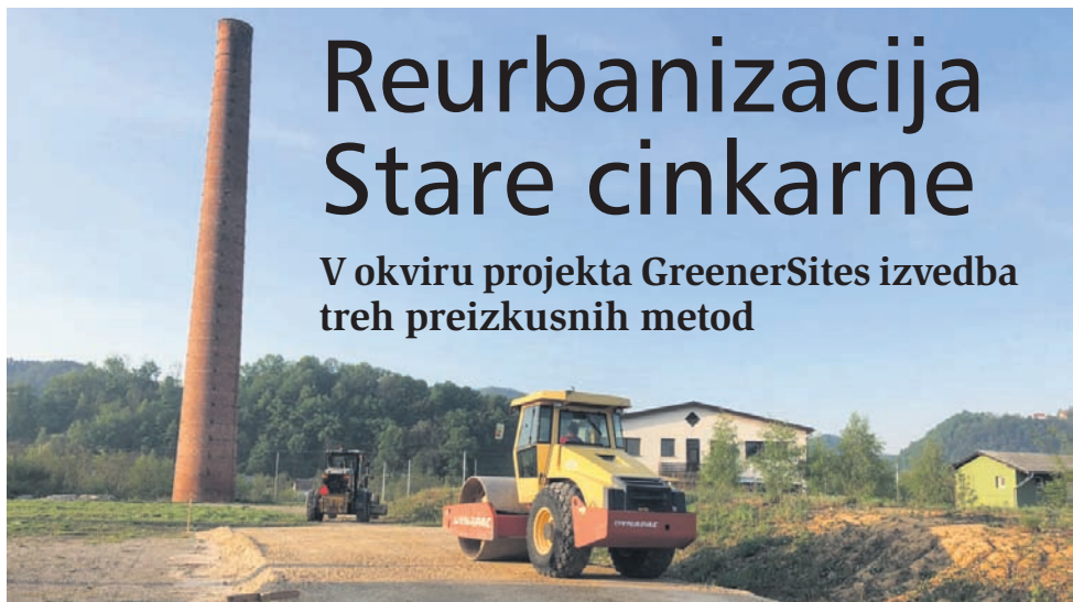
Preizkusno izvajanje hladne reciklaže v okviru reurbanizacije Stare cinkarne.
