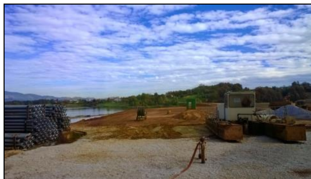
Slika 16: Zasipavanje akumulacije s suho sadro – izpodrivanje vode (vzrok za izgubo statusa velike pregrade v prihodnosti).
