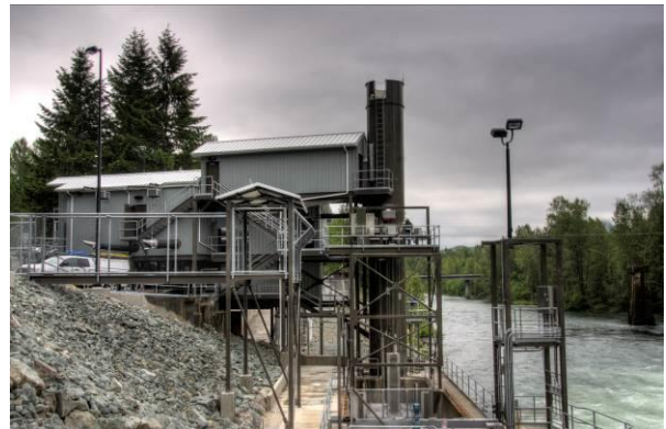
Slika 3: Naprava za zajem rib na reki Baker z dvigalom za ribe (vir: www.flickr.com )
