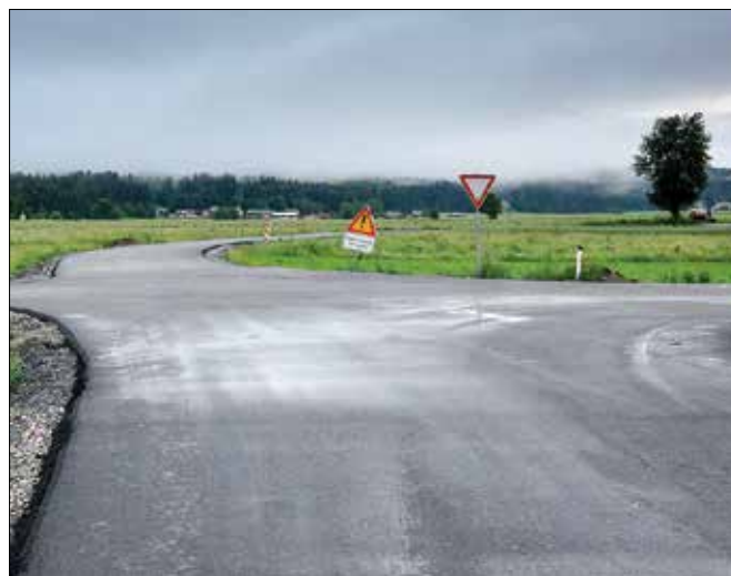
Sanirano in razširjeno cestišče že ima novo asfaltno prevleko. (Foto: Barbara Rozoničnik)
