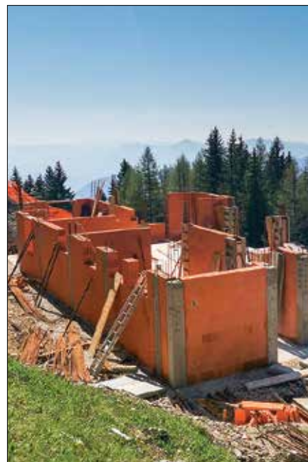
Groba gradbena dela bodo ob nadaljevanju ugodnega vremena zaključena v dobrem mesecu dni.
