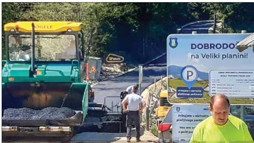
Cestni odsek od Kranjskega Raka do parkirišča pri kamnolomu na Rakovih ravneh je asfaltiran. (Foto: arhiv GP Brlec)
