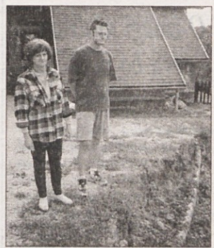
KOSTEVČEVI IN PLAZ - Ob hiši Kostevčevih je plaz razkril kabel, po katerem dobivajo elektriko ob Poti na Armes. (Foto: L. M.)
