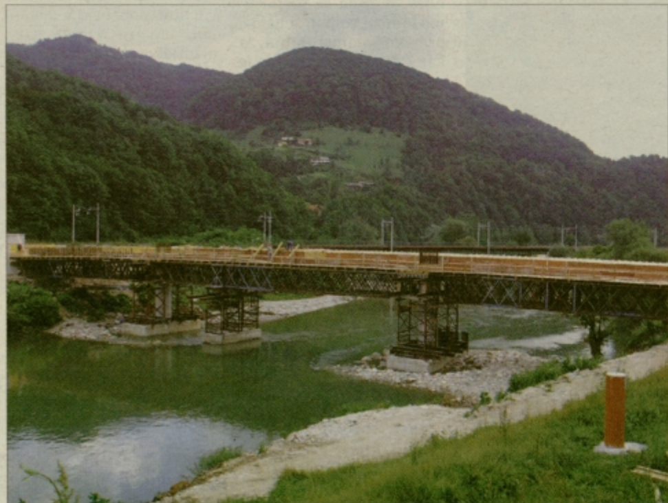
Gradnja brvi čez Savinjo pri Tremerjah dobro napreduje.
