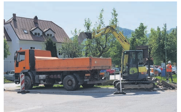
Središče Dobrne postaja v teh dneh gradbišče.
