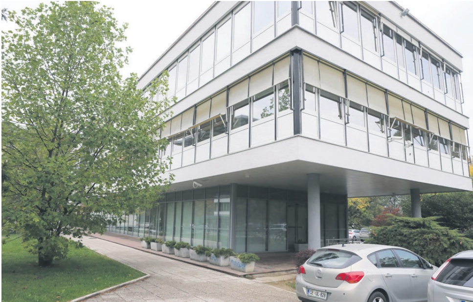
Steklena direkcija je bila zgrajena leta 1959 in v celoti obnovljena leta 2004. Pri obnovi je bilo upoštevanih vseh pet načel moderne arhitekture mednarodnega sloga, gre za ravno streho, horizontalno okno, konstrukcijo na pilotih, svoboden tloris in svobodno kompozicijo fasade.
