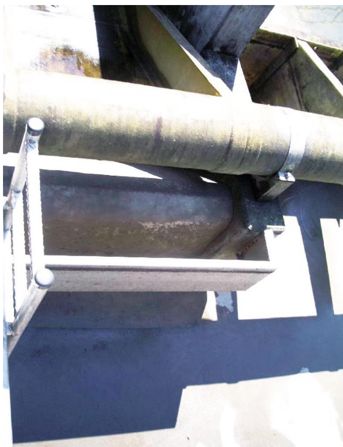
Slika 9 • Pogled na prelivni rob plovca s potopno steno
