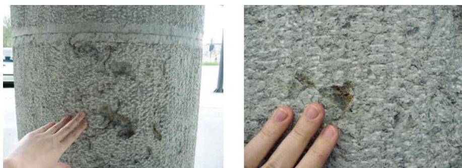
Slika 5 • Izpadanje kosov – levo: izpadanje v večjem obsegu; desno: izpadanje v manjšem obsegu
