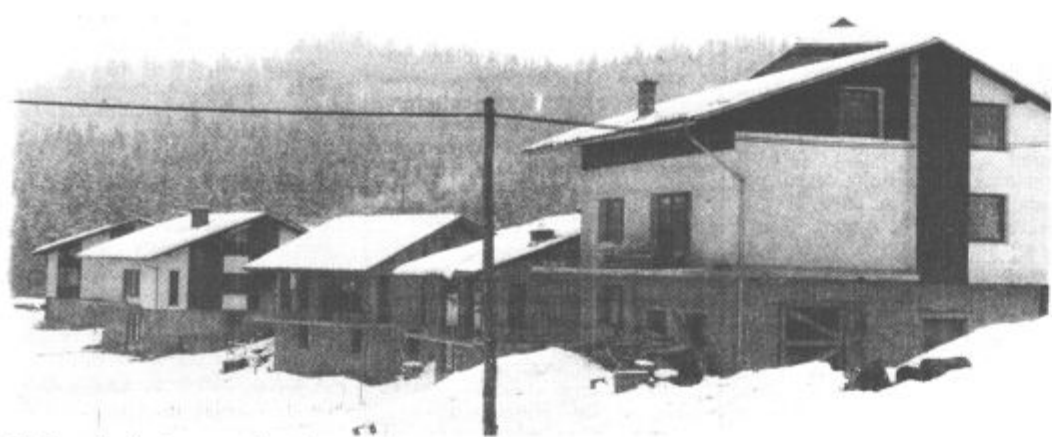
Coning v Podkraju z neurejeno kanalizacijo
