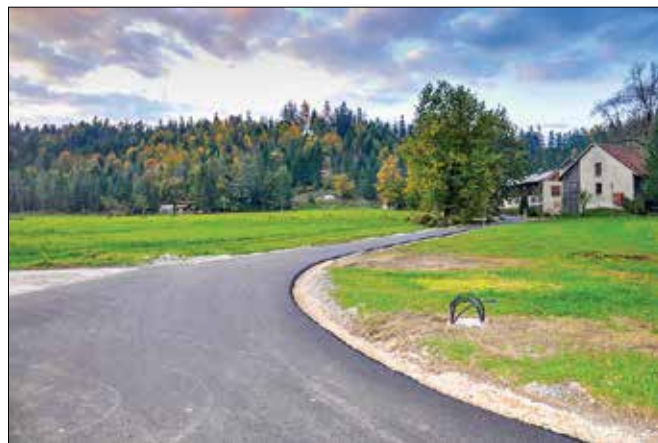
Obnova lokalne ceste Spodnje Kraše-Brdo se v teh dneh zaključuje.
