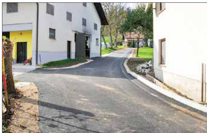
Asfaltiran makadamski odcep lokalne ceste proti kmetiji Praznik (Birš)
