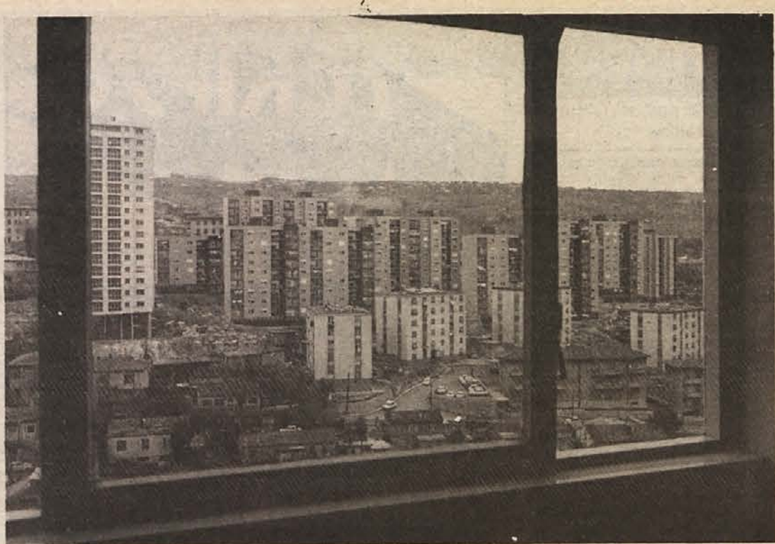
Gradbinci splošnega gradbenega podjetja Pionir iz Novega mesta so se v zadnjih letih specializirali za hitro gradnjo stanovanj. Pri gradnji uporabljajo posebne tunelske opaze in drugo sodobno tehnologijo. Največja gradbišča imajo v Ljubljani in Zagrebu, novomeška temeljna OZD pa na Reki. V tem luskem mestu so zgradili sosesko s 350 stanovanji, prevzeli pa so tudi druga gradbena dela. Gradnja na Reki je težka in zahtevna predvsem zaradi strmega in skalnatega terena, kjer vzame gradbincem veliko časa komunalno urejanje stavbnih zemljišč. (Foto: M. Vesel)
