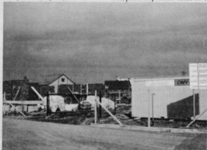
Živahno gradbišče nasproti gostilni Prosnik. Foto: Štefan Hožyan
