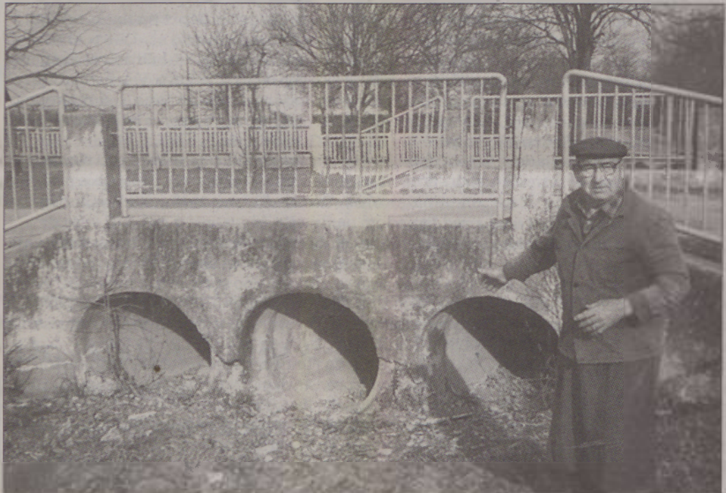
Štefan Mesarič iz Satahovec je pomagal graditi ta most. Predvsem je delal cevaste opaže. In leta 1956 se je z »ladjo« vozil proti Hrastju - Moti. Takrat je voda segala skoraj do vrha te mostne ograde. Foto: F. Š.
